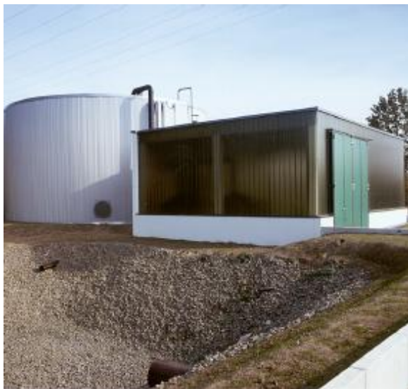
Misch- und Ausgleichsbehälter / Tank for mixing and equalization
