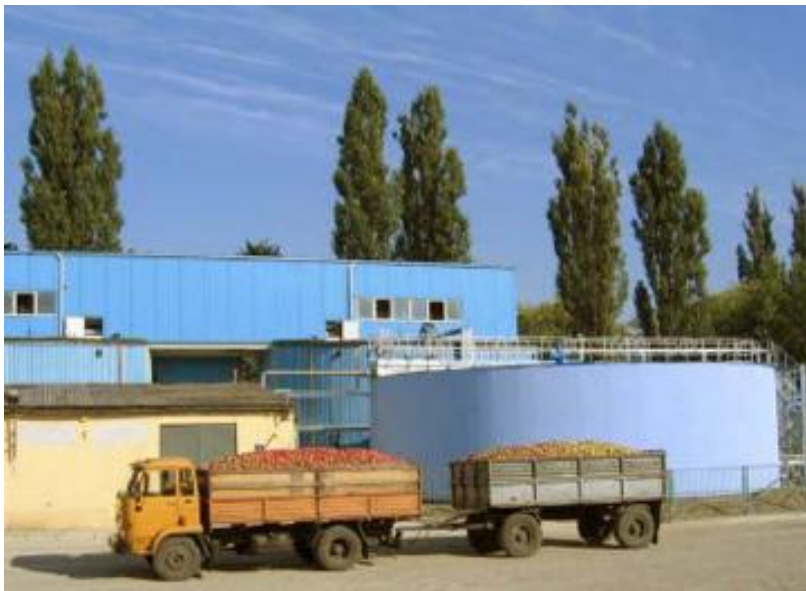
Außenansicht der Abwasserbehandlungsanlage
