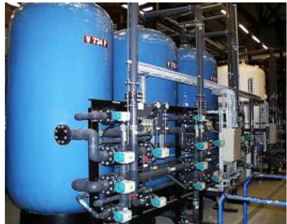
Envochem® ION Schwermetall-Ionenaustauscher Envochem® ION Heavy Metal Ion Exchanger
